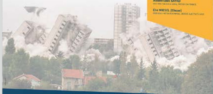
Des immeubles de la zone BSL de quartier d'habitat social à Paris (Dreier, photographie, apak)
