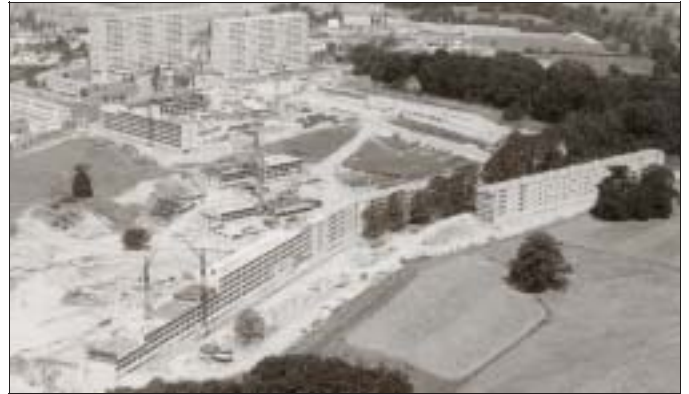
LIMOGES, 1961. Voici la construction du quartier de La Bastide, avec les barres Gauguin (en haut à gauche) qui doivent être prochainement détruites. Des centaines d'ouvriers du bâtiment et des travaux publics, dont beaucoup d'étrangers, ont participé aux chantiers de la périphérie des villes.
